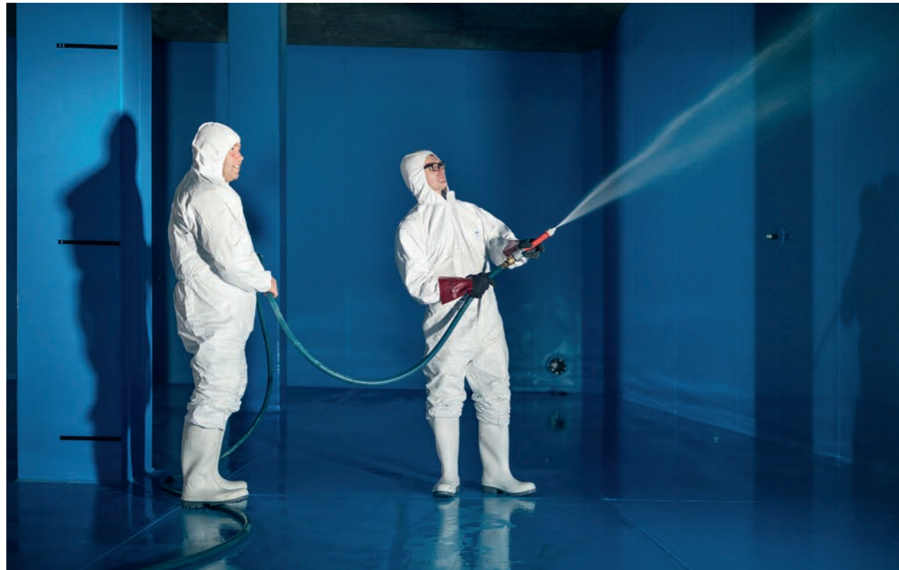
Christian Wiedmer und Jan Seifert bei der Reinigung des Wasserreservoirs.
